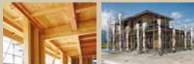
木造軸組工法にプラス全面に構造用木質ボードを使用する事により、気密性・断熱性などの外からの力を面で受け止めるため、耐久性・耐震性を高めています。
