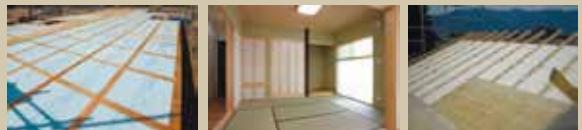
外気温の影響を和らげ、屋内の温度を一定に保つ効果があります。床には、ポリスチレンフォームを使用し、軟化・変形・変質する事はありません。壁には施工性が良く軽量なグラスウール。屋根には通気層を確保できる、ポリスチレンフォームを使用しています。
