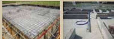
建物全体の重量を支える基礎は、鉄筋コンクリート造りのベタ基礎。面全体で建物を支える構造になっているため、地震などの衝撃を地盤へ逃がす事が出来ます。また地盤の影響も受けにくい形状です。
